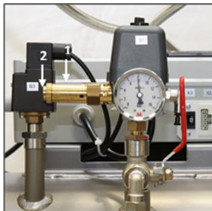
Obr. 25: Kontrola poistného ventilu
